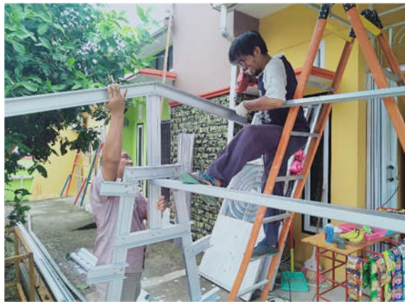
Gambar 2. Perakitan instalasi hidroponik sistem DFT
