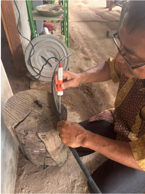
Foto 6. Proses Pelubangan Pipa Lateral
