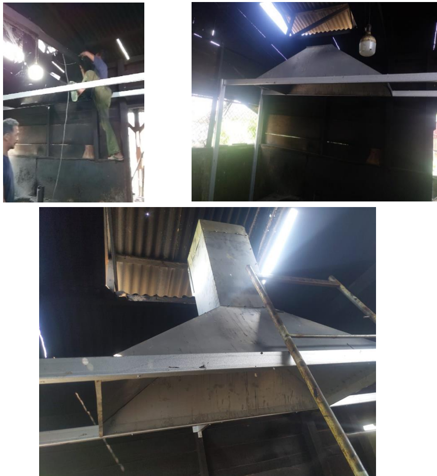
Gambar 13. Pemasangan ekhaust hood
