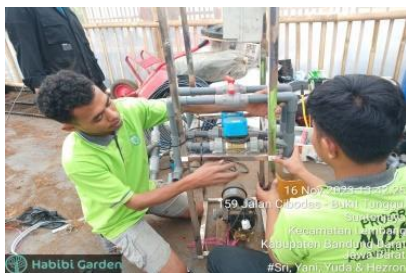
Gambar 3. Pemasangan sistem habibi
