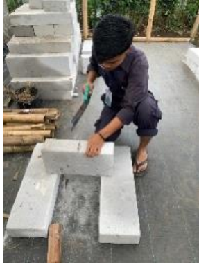
Gambar 9. Pemotongan hebel dan pemasangan tali tambang
