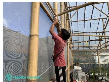
Gambar 8. Pemasangan kawat ajir
