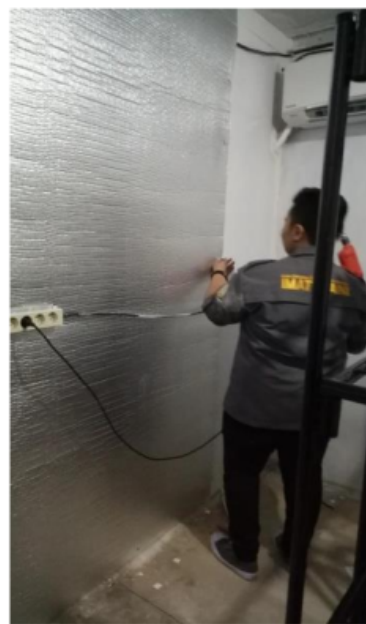
Gambar 8. Pemasangan AC dan Proses Pelapisan Dinding dengan Bahan Pelapis Khusus untuk Menahan Kalor
