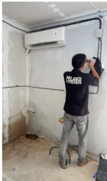
Gambar 8. Pemasangan AC dan Proses Pelapisan Dinding dengan Bahan Pelapis Khusus untuk Menahan Kalor
