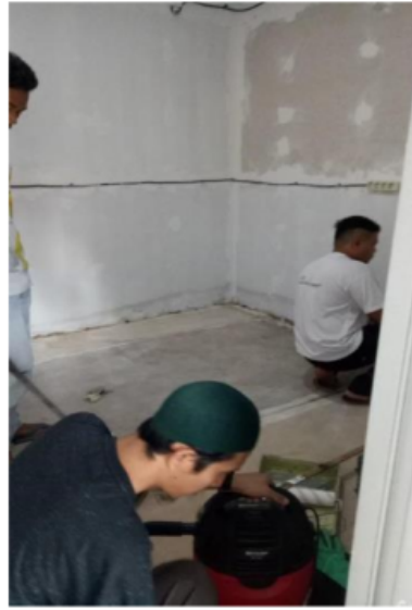
Gambar 7. Proses Pelapisan Sambungan Dinding GRC dengan Silicon, Pembuatan Instalasi Listrik dan Pengecatan Tahap 1 Dinding dengan Cat Watter Proof
